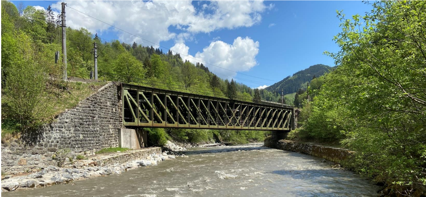
EB Salzachbrücke Eschenau Gleis 1 Strecke Salzburg – Wörgl km 78.510, Gleis 1
